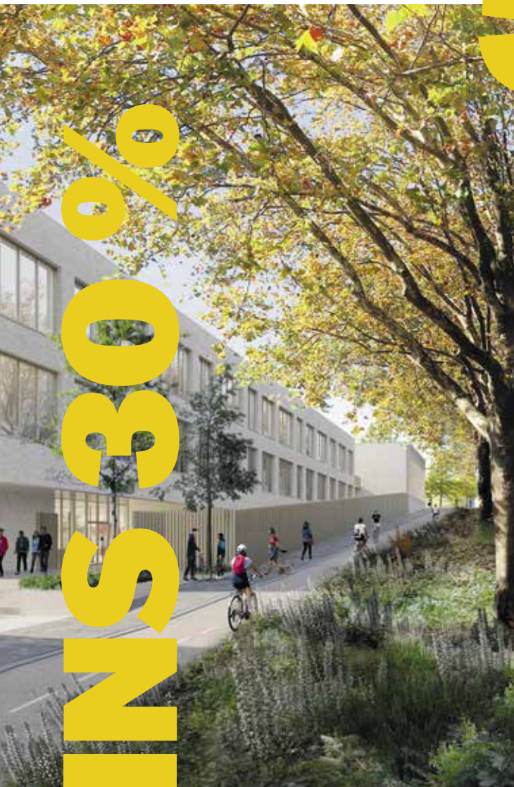
Le futur collège Gustave-Eiffel à Châtenay-Malabry.
